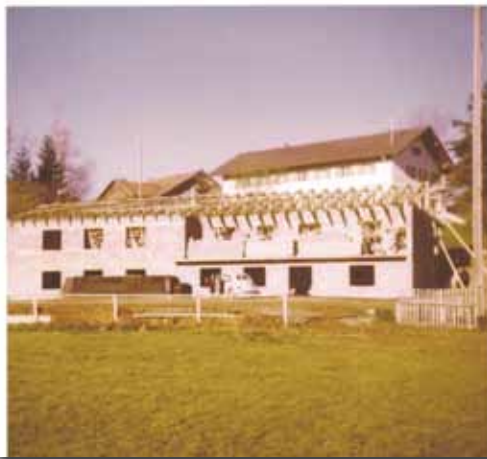
Schützenheim im Rohbau
